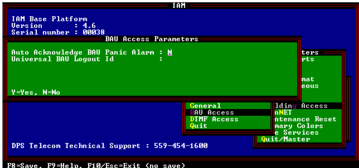
Fig. M22.22 - BAU Access Parameters screen
